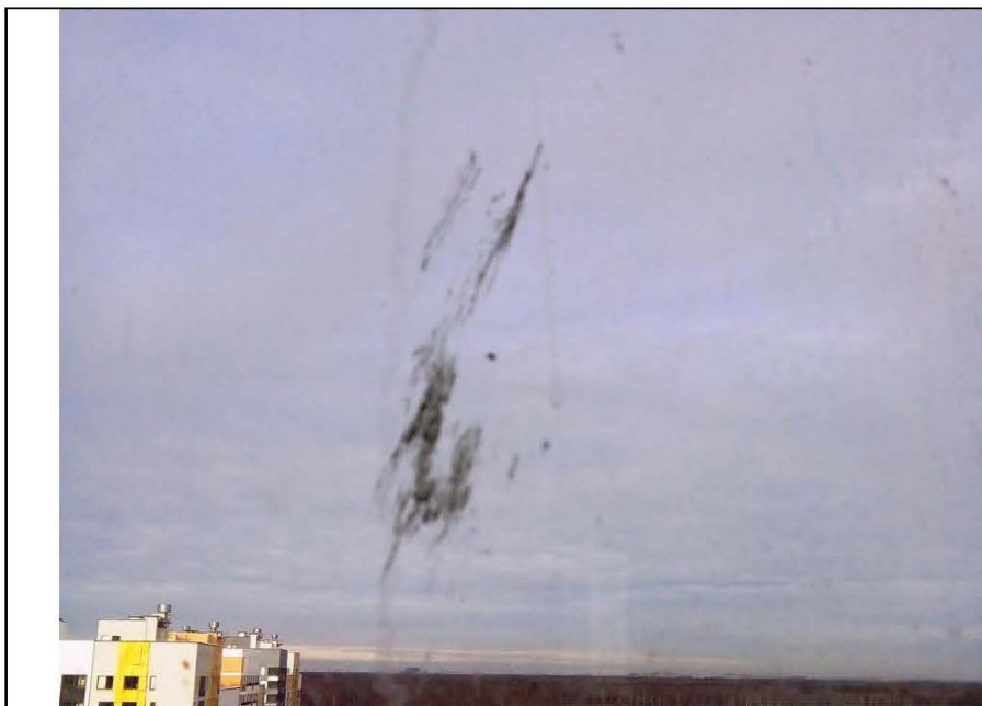
Фото № 34. Загрязнения поверхности стекла в стеклопакете оконного блока в кухне-столовой.
