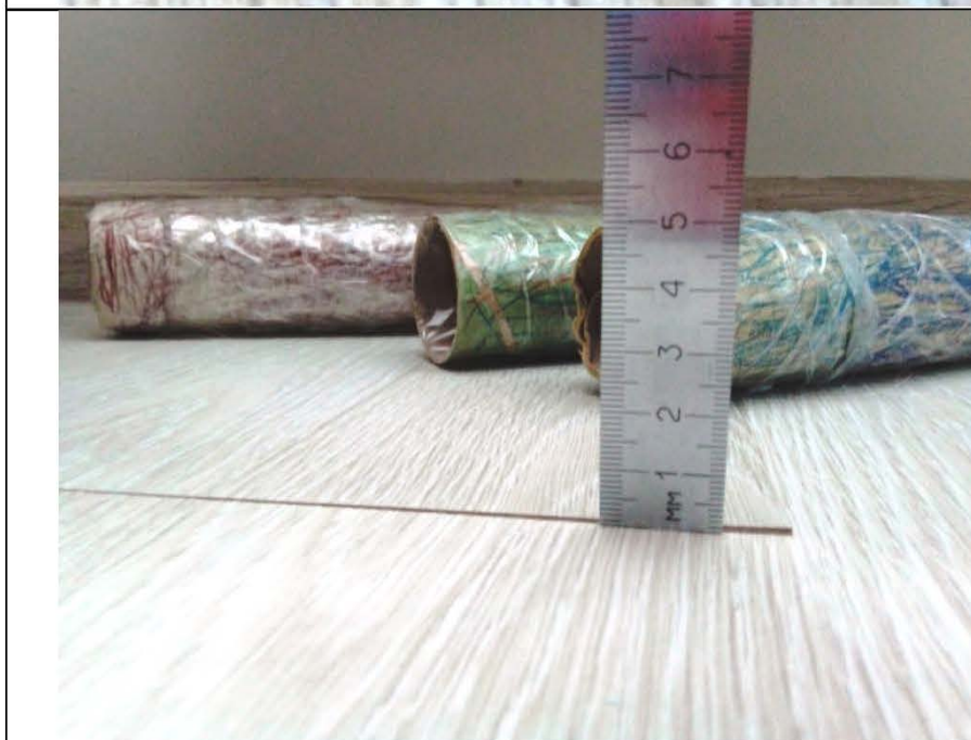
Фото № 23. Приподнятая кромка на поверхности напольного покрытия в спальне № 1.
