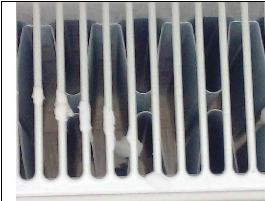
Фото № 64. Загрязнения отопительного прибора в кухне-столовой.
