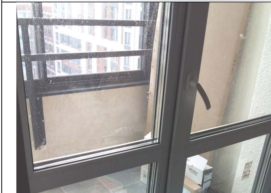
Фото № 41. Ручка створки (полотна) балконного дверного блока в спальне № 1 не фиксируется в положении «Закрыто».
