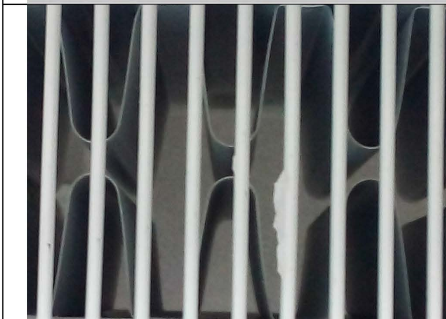
Фото № 66. Загрязнения отопительного прибора в спальне № 3.
