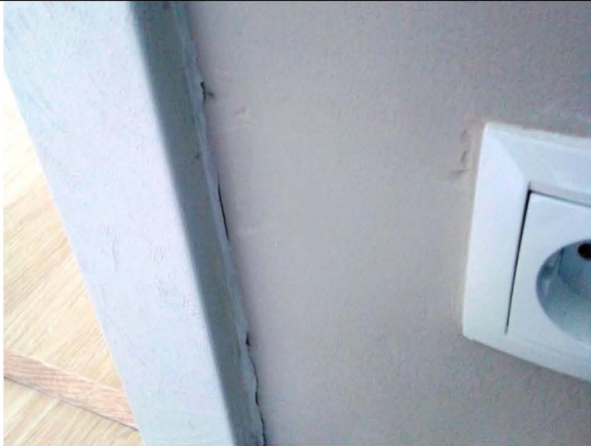
Фото № 19. Ненадежное соединение наличника дверного блока в спальне № 3.
