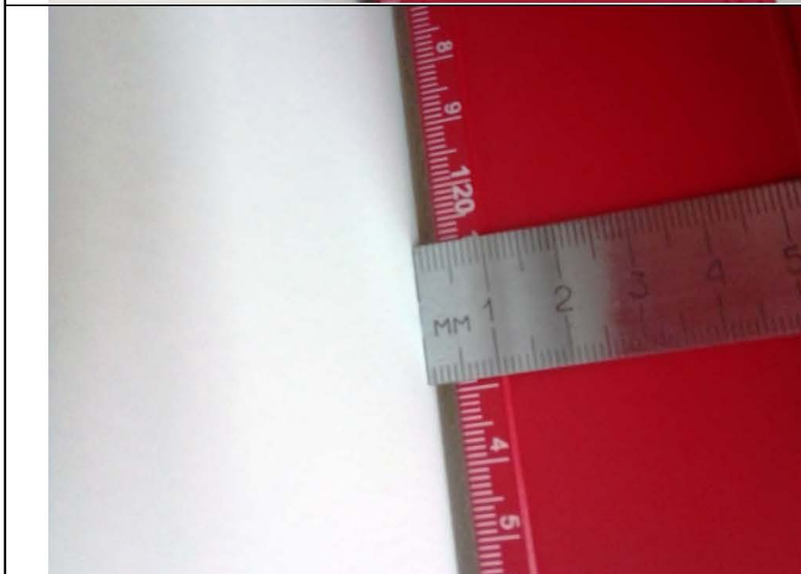
Фото № 17. Измерение отклонения от вертикали стены в спальне № 3.
