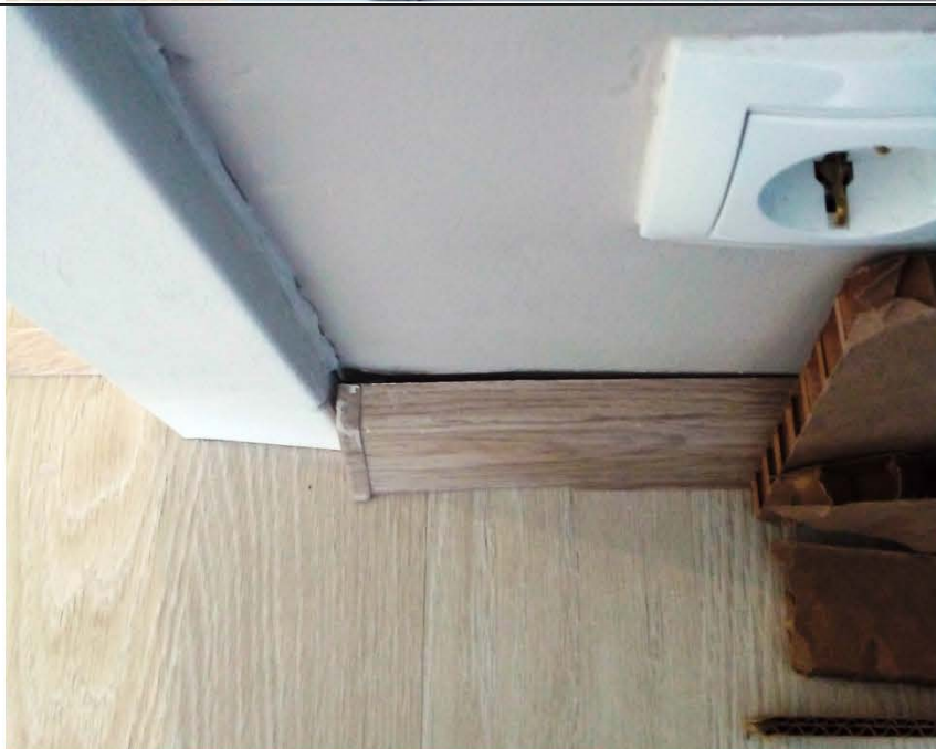
Фото № 20. Зазор (щель) между плинтусом и стеной (перегородкой) в спальне № 3.
