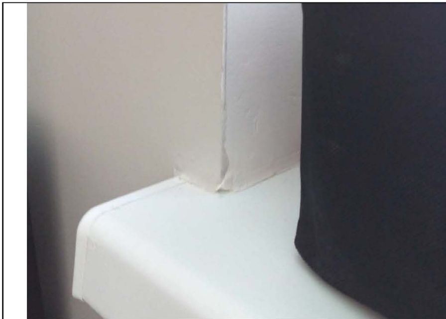
Фото № 37. Неровности поверхности оконного откоса в кухне-столовой.
