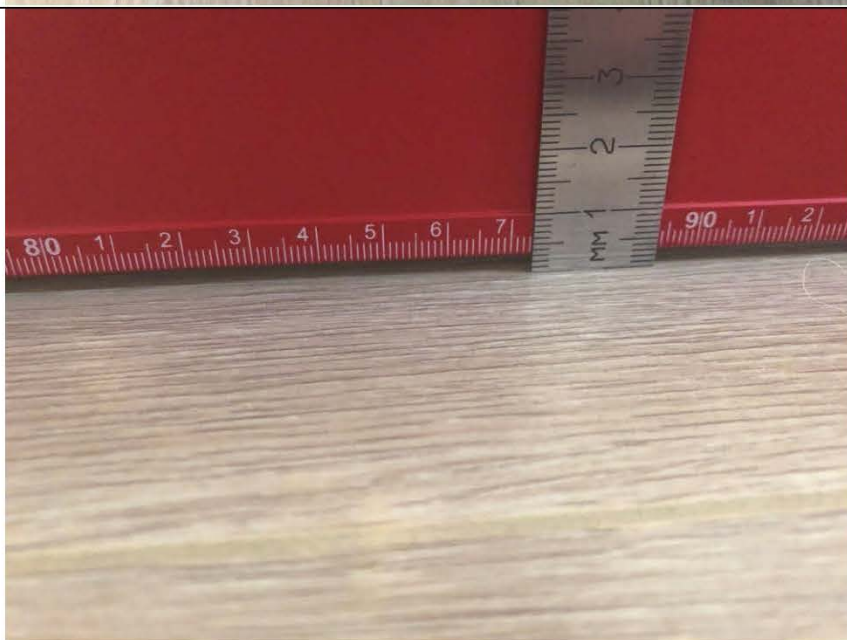
Фото № 21. Отклонения поверхности напольного покрытия (ламината) от плоскости в спальне №3.
