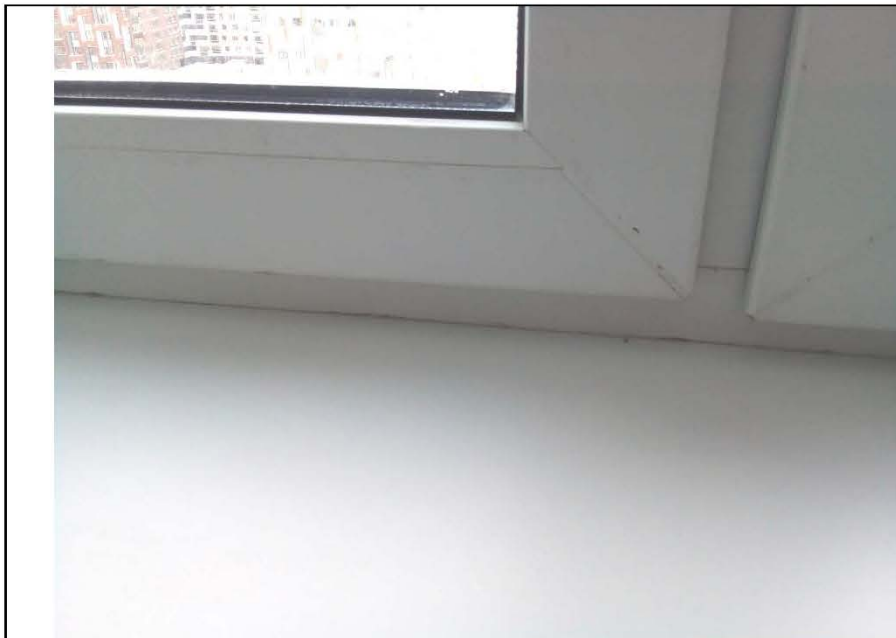
Фото № 40. Неплотное, негерметичное примыкание подоконной доски (подоконника) в кухне-столовой.
