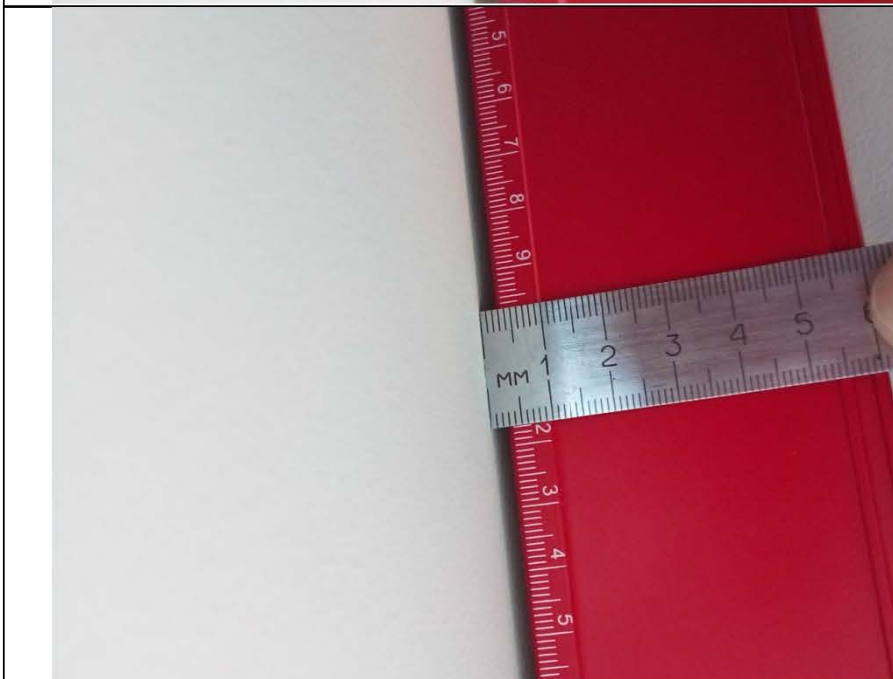
Фото № 15. Измерение отклонения от вертикали стены в спальне № 1.
