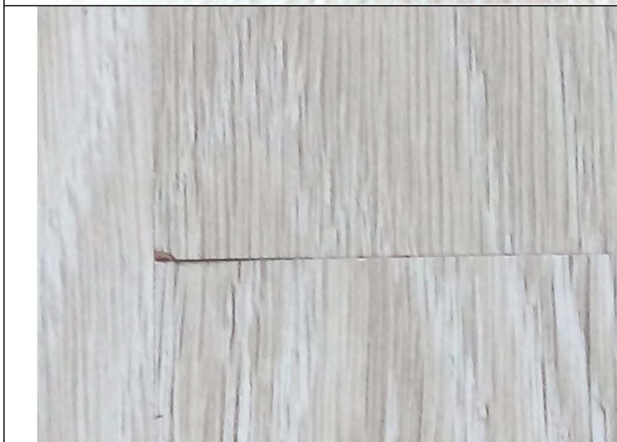
Фото № 24. Выбоина на поверхности напольного покрытия в спальне № 1; зазор (щель) между смежными элементами напольного покрытия в спальне № 1.
