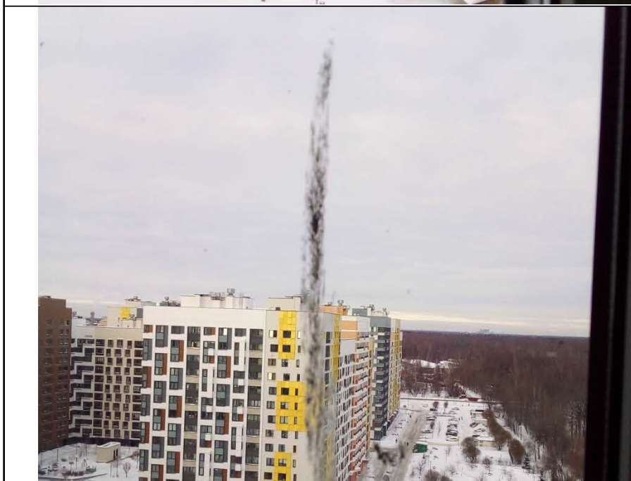
Фото № 36. Загрязнения поверхности стекла в стеклопакете оконного блока в кухне-столовой.
