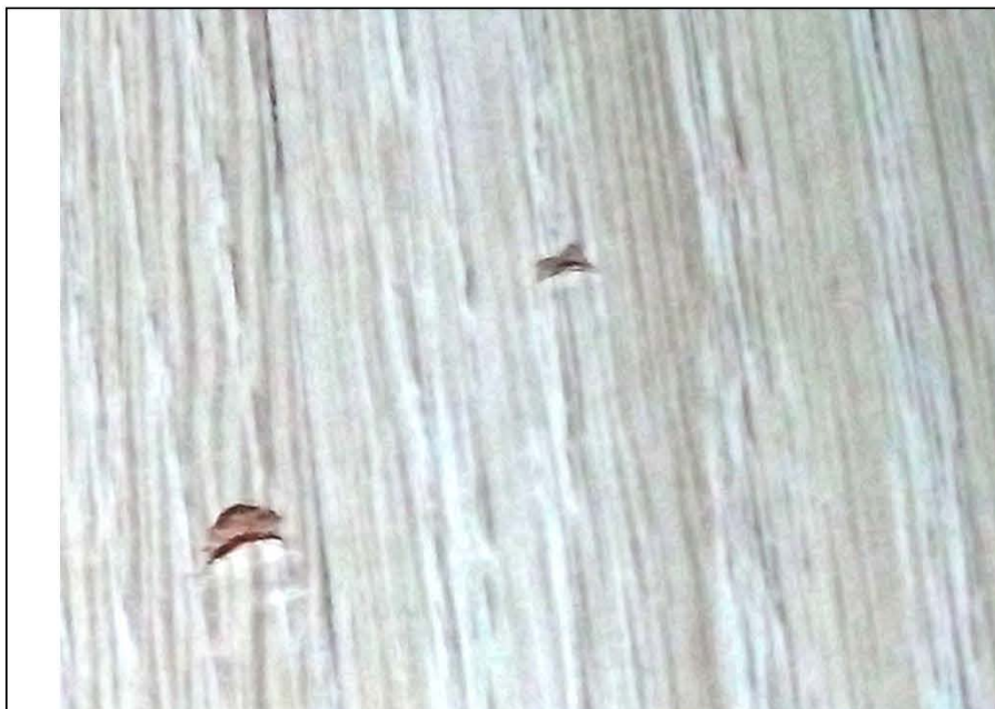
Фото № 22. Выбоины на поверхности напольного покрытия в спальне № 1.
