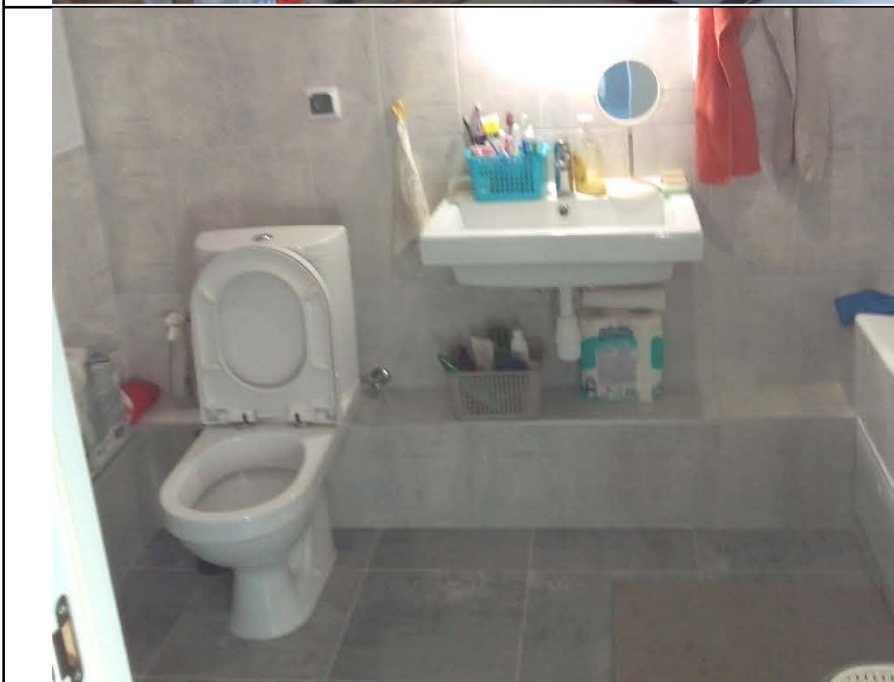
Фото № 12. Общий вид санузла № 1 в квартире.
